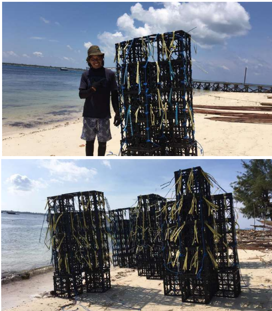
Gambar 2.7 Unit-unit sub-modul yang telah dirangkai menjadi modul rumah ikan dan telah dilengkapi dengan tali atraktor serta siap untuk diangkut menuju ke lokasi peletakan (penenggelaman) (PT Pertamina Gas OEJA, 2020c)
