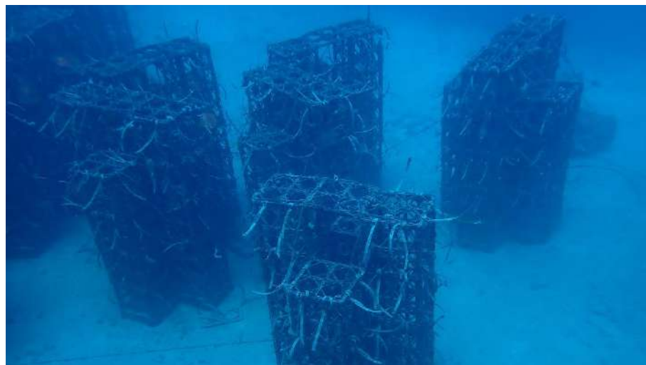
Gambar 5.1 Gambaran umum kondisi rumah ikan ( fish apartment ) pada Oktober 2021; semua modul masih berdiri kokoh dan dalam kondisi yang baik (Survei primer, 2021)
